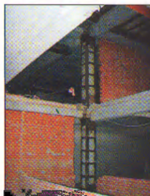
Усиление каркаса общественного здания, Москва
